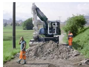
Déconstruction d'une piste, en reculant et en circulant sur la piste
