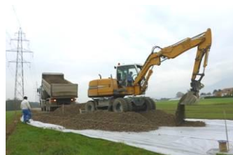
Mise en place d'une piste provisoire sur un géotextile, sans circulation sur le sol en place
