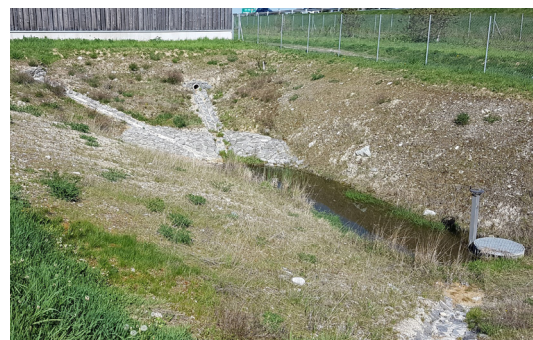
Bassin de rétention couplé à un ouvrage de régulation des eaux (© Atelier Nature et Paysage)
