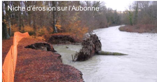
Arbres ancrés protégeant la berge sur l'Aubonne § 3.9 OFEV 2010
