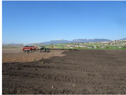
Figure 6 : Transport et épandage des matériaux terreux
