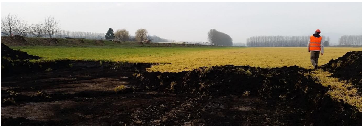
Figure 2 : Décapage de la terre noire sur les emprises définitives du chantier
