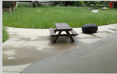
Revêtement en béton
