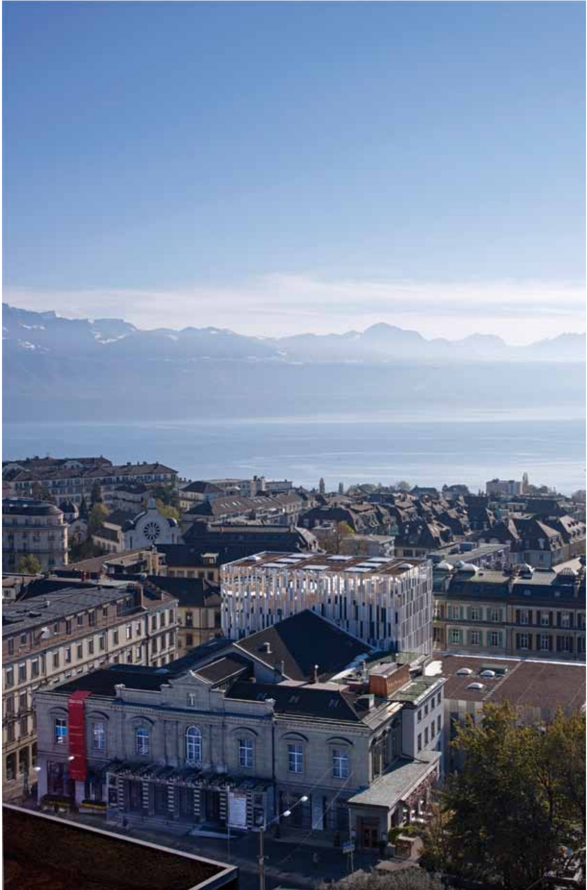
Les travaux se sont achevés en septembre 2012.
