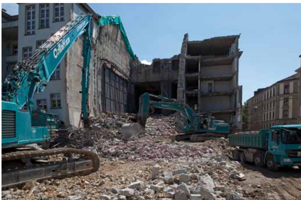
Les travaux de rénovation ont débuté en mars 2010.
