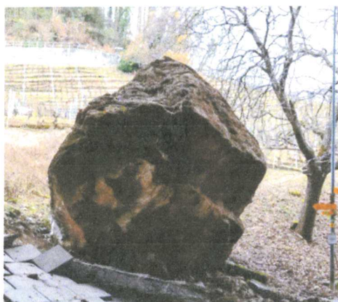
Corsier, chute d'un rocher de 150 tonnes
