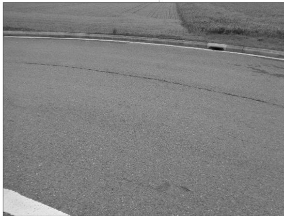
Photo 3 – carrefour giratoire de Terrebonne
