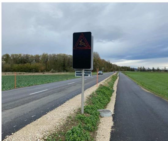
Figure 12 : Système d'avertisseur de la présence de gibier de type Calstrom
