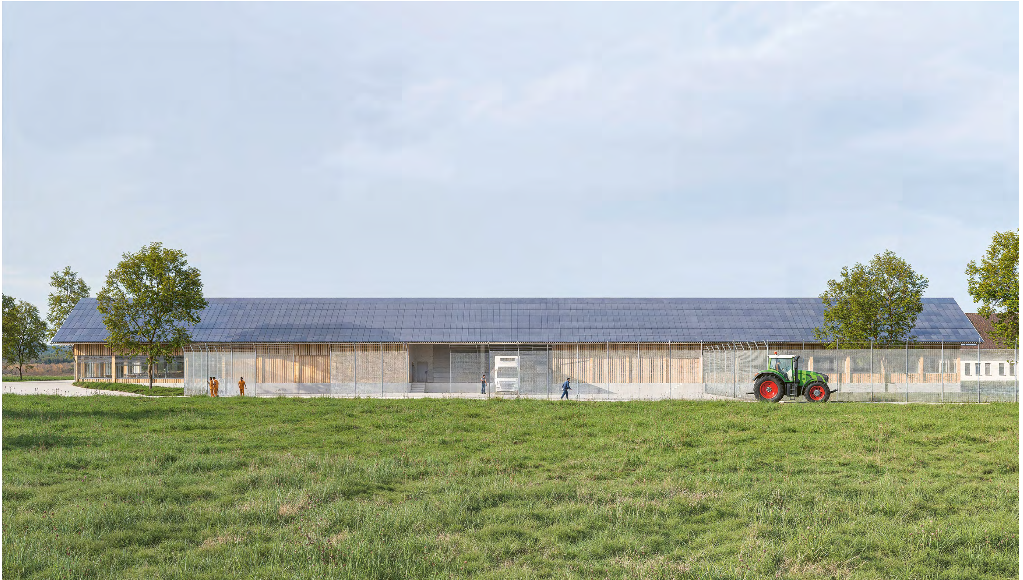
Façade Sud entrée de l'espace logistique
