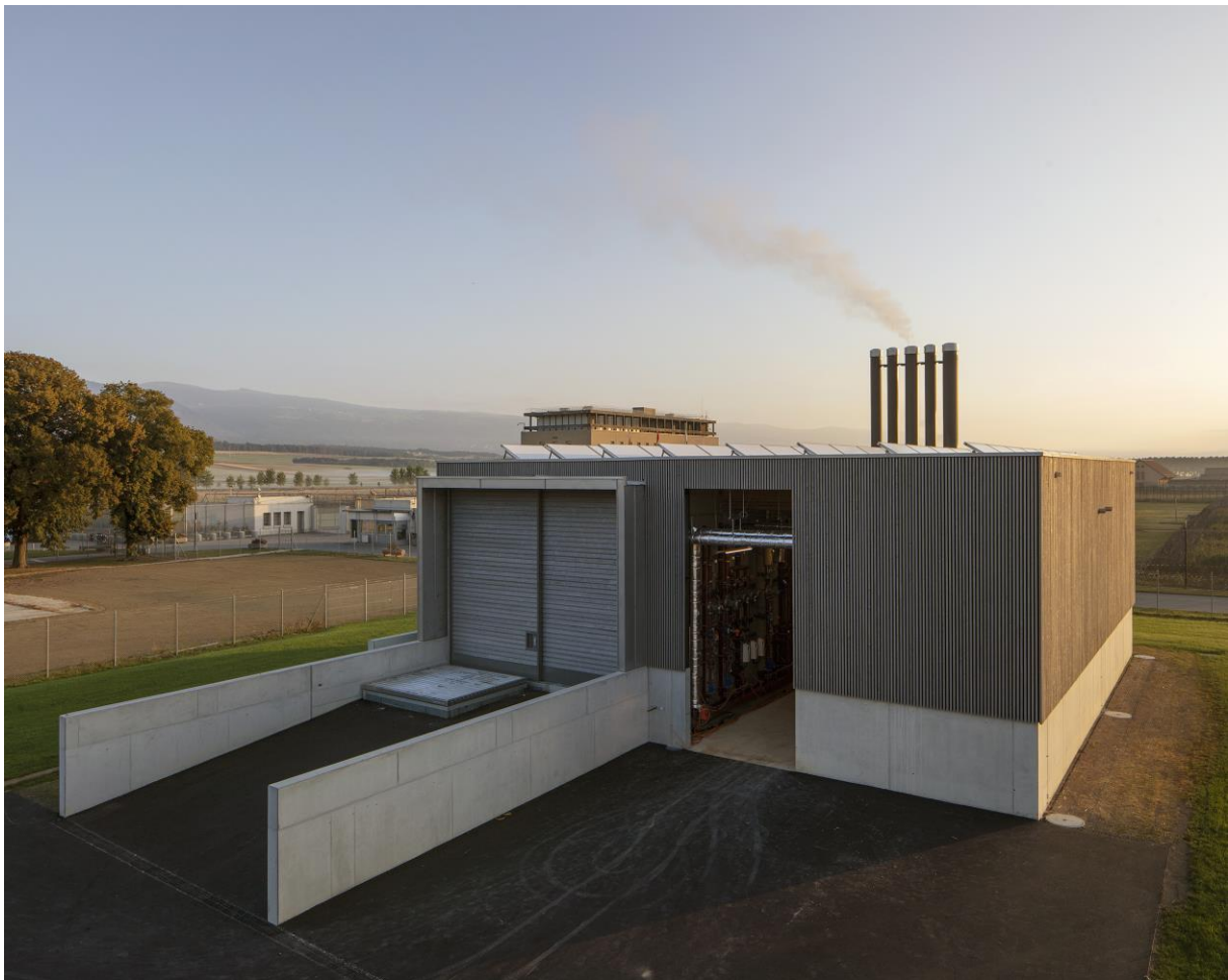
Figure 1 – Nouvelle chaufferie des E.P.O
