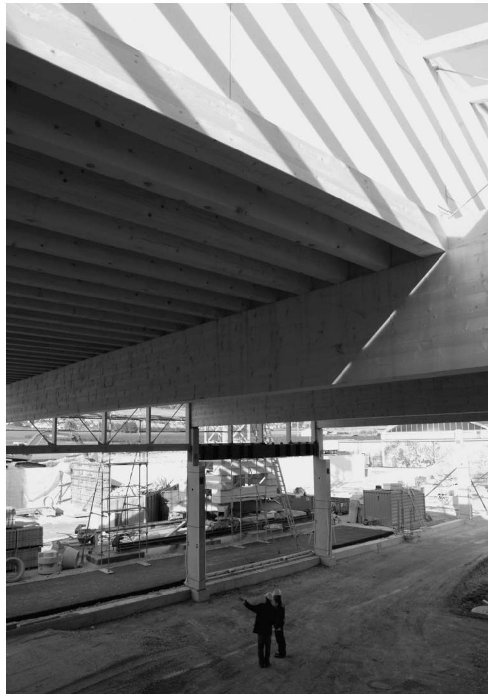
Le chantier: vue intérieure, novembre 2004
