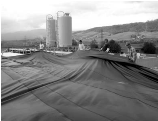
L'étanchéité EPDM se déroule rapidement, sa mise en place n'est que peu dépendante des conditions météorologiques.
