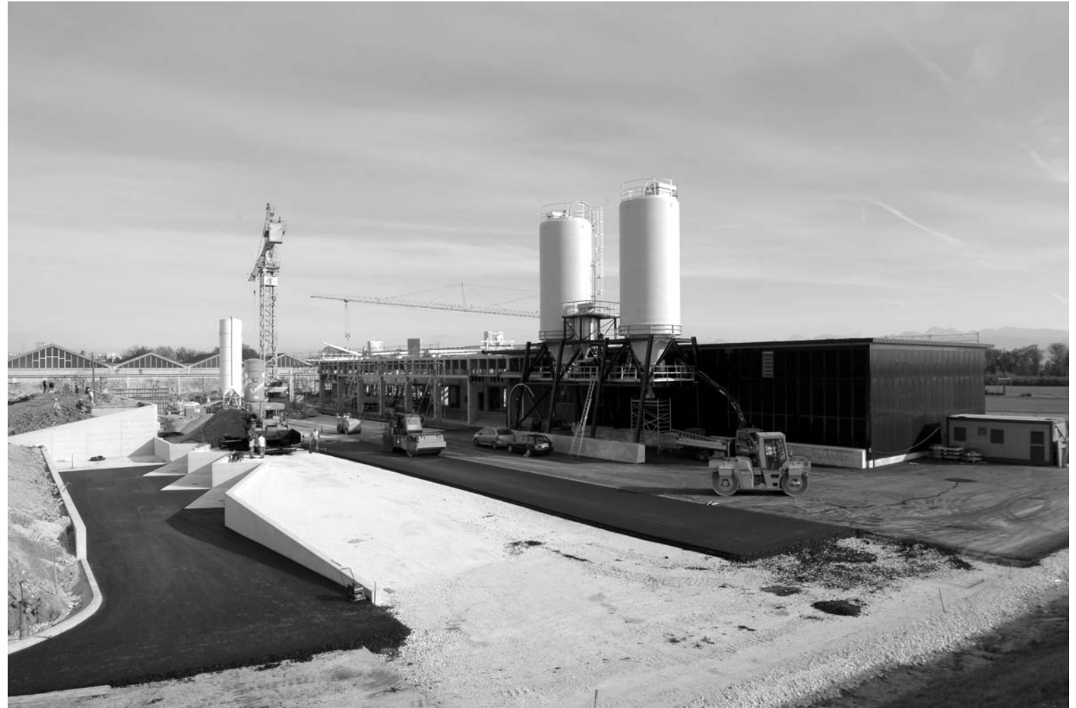
Le chantier: vue générale depuis le nord, novembre 2004
