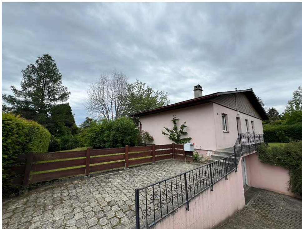
Façade nord-est – Entrée garage et entrée habitation
