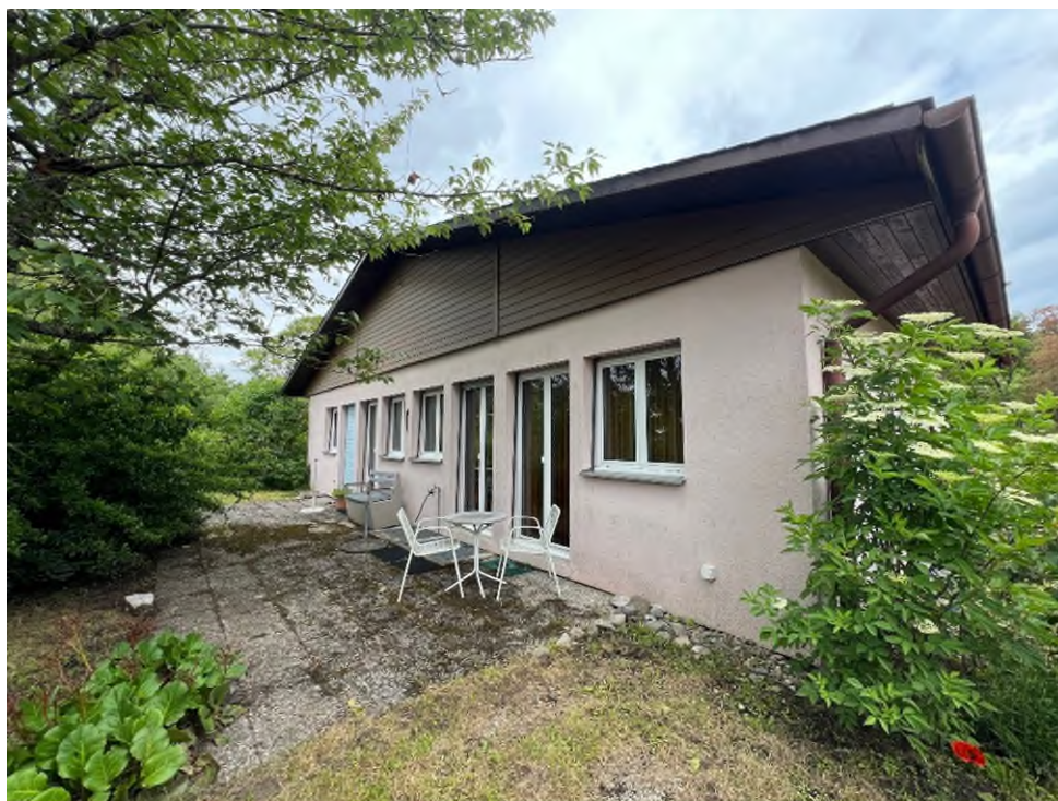
Façade sud - Terrasse
