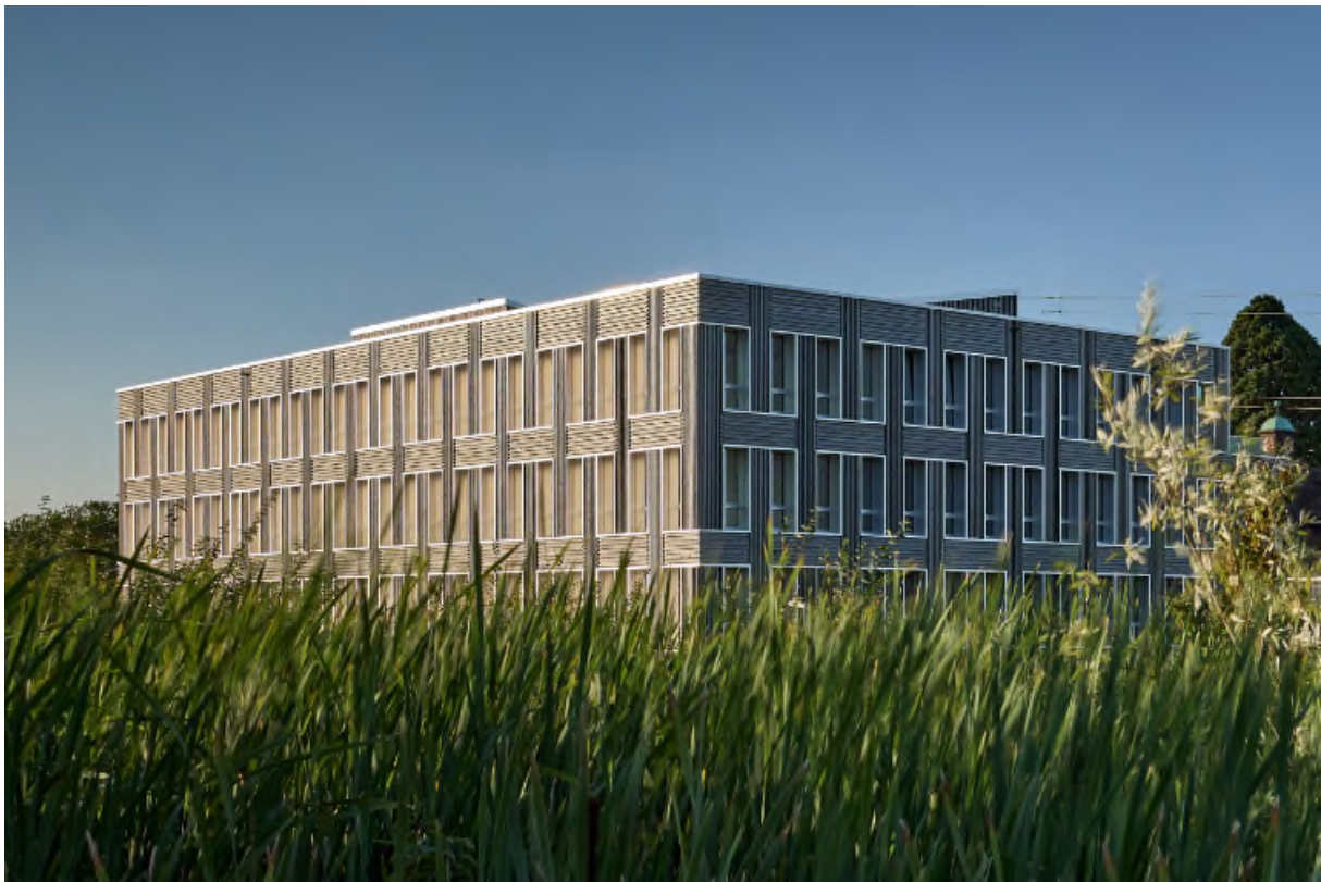
Figure 1 – MEV – Maison de l'environnement - Avenue de Valmont 30B – Lausanne
