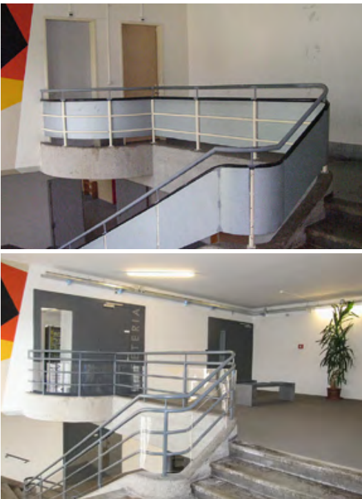
escalier avant/après travaux
