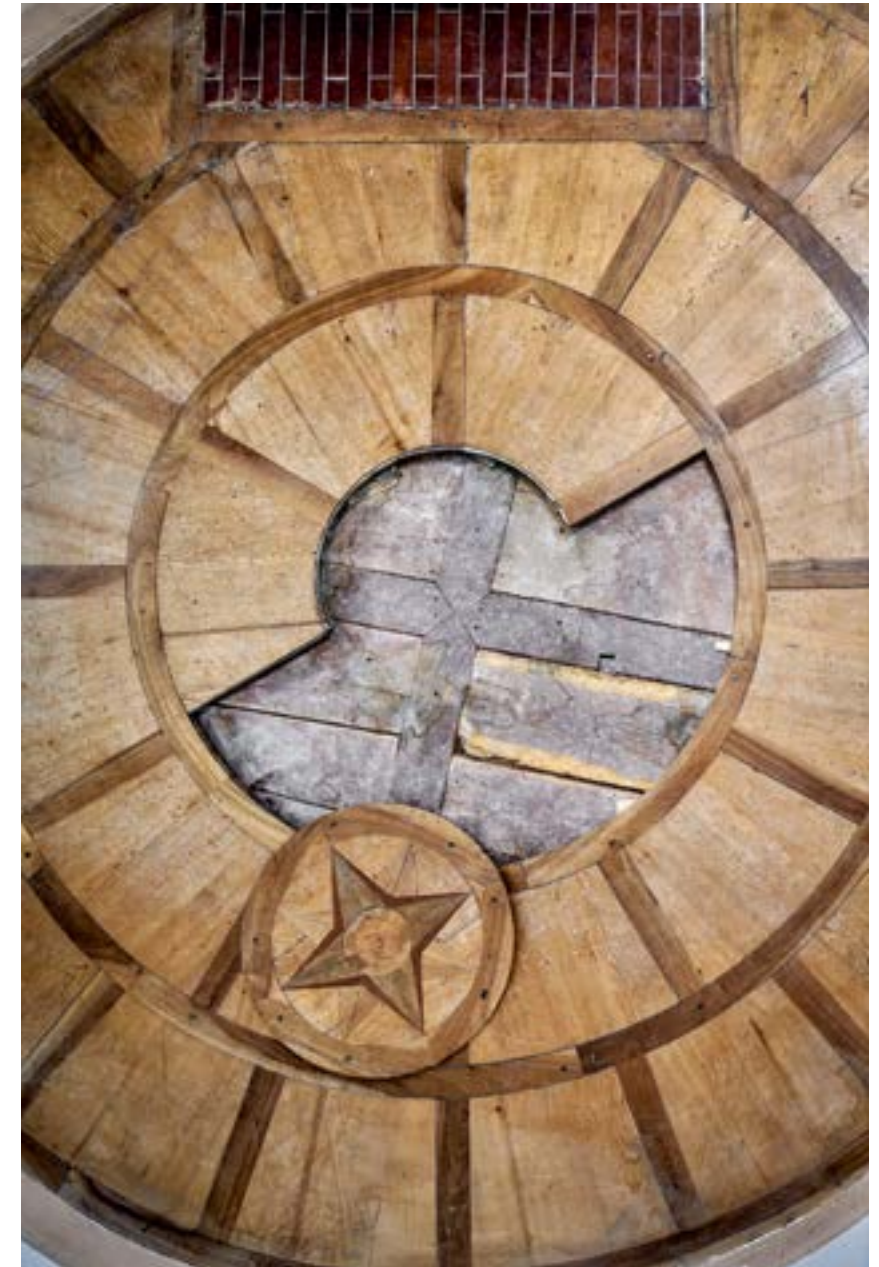
I11.52 Redécouverte d'un parquet à croix du XVIII e siècle sous un parquet à rose des vents du XX e siècle.
