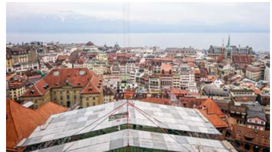
Ill. 28 Pose de la couverture provisoire.
