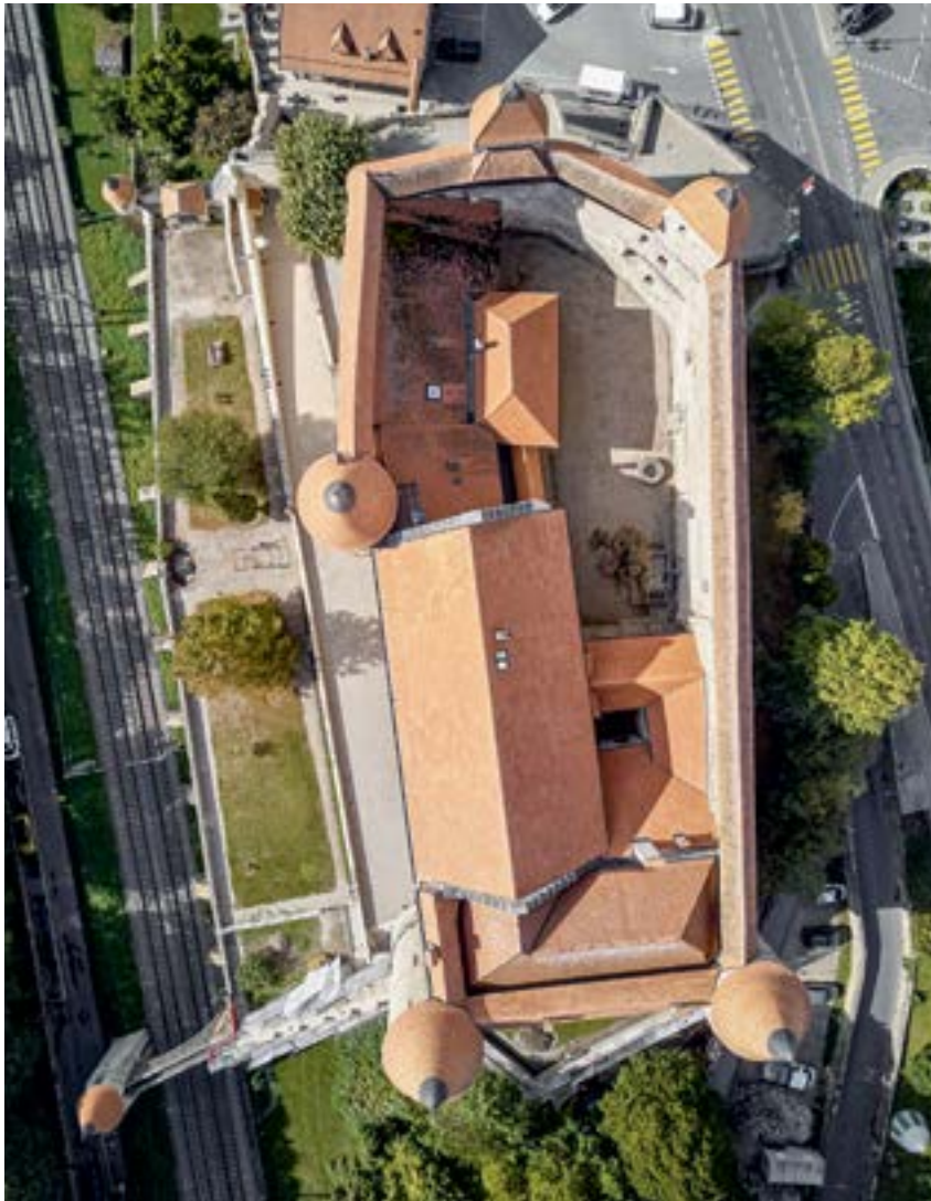
Ill . 51 Le château de Grandson hors d'eau après la rénovation des murs et des toitures.
