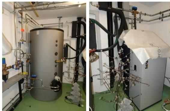
La production d'eau chaude sanitaire est assurée par la pompe à chaleur et/ou les cinq panneaux solaires installés en toiture (5 x 1 m<sup>2</sup>). L'eau chaude sanitaire est stockée dans un réservoir TML de 400 litres.
