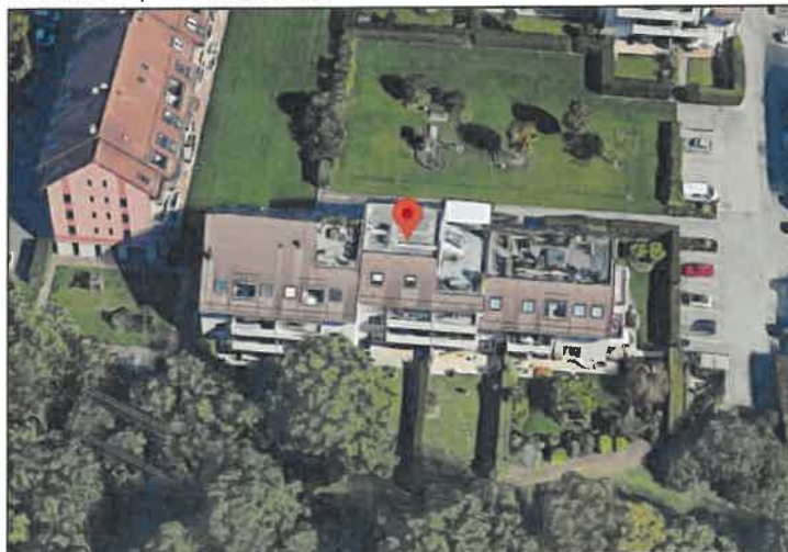
Vue du bâtiment depuis l'Ouest.
