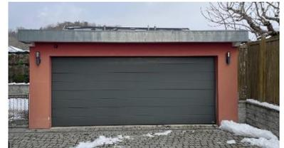
**Garage** : bâtiment ECA N° 508, d'un volume de 96 m<sup>3</sup> construit en 2010. Il s'agit d'un garage pour deux véhicules, doté d'une porte à section automatisée. Bâtiment surmonté d'un toit plat dont la ferblanterie est en cuivre. La construction est raccordée au réseau électrique. Le bâtiment est globalement en bon état, aucuns travaux ne sont à prévoir sur le moyen terme.
