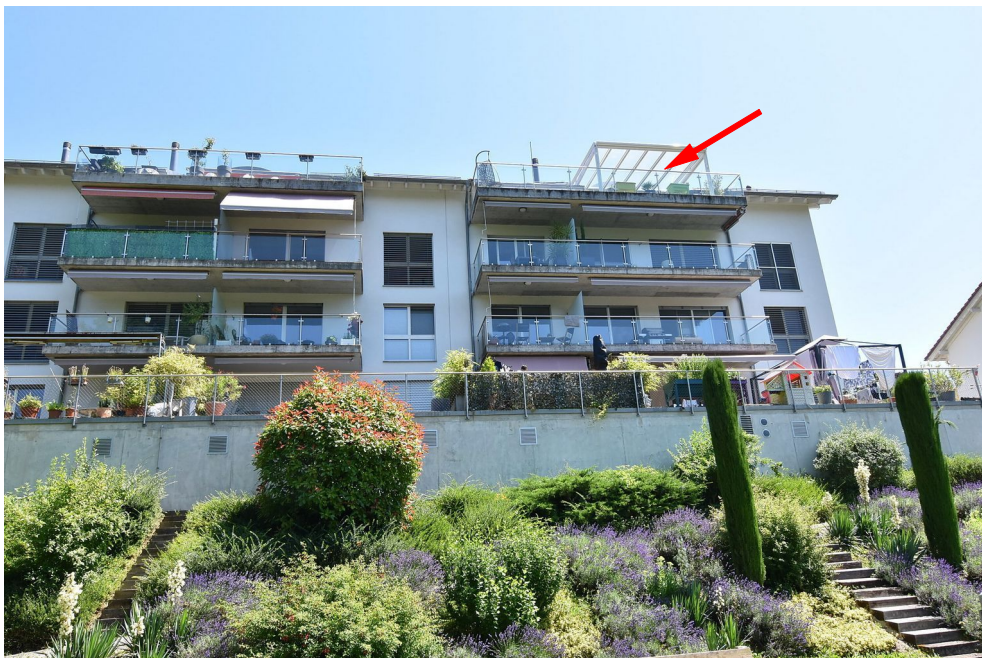
Photo N°6 Façade Ouest (balcon du lot de PPE aux combles)
