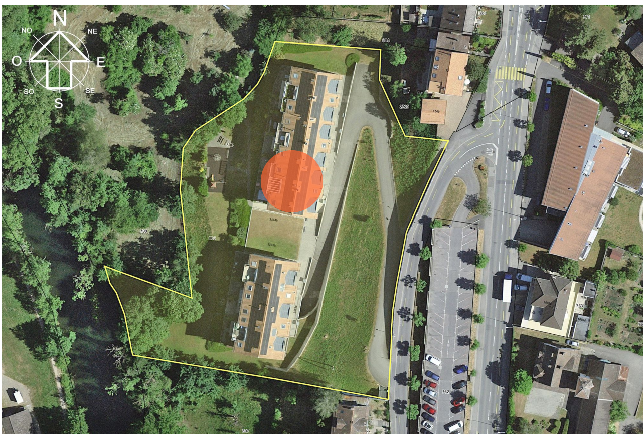
Photo aérienne avec emplacement de l'appartement et périmètre de la parcelle de base en jaune
