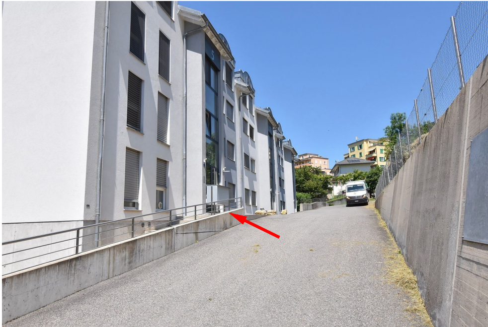
Photo N°3 Façade Est (entrée N° 5 donnant l'accès au lot de PPE)
