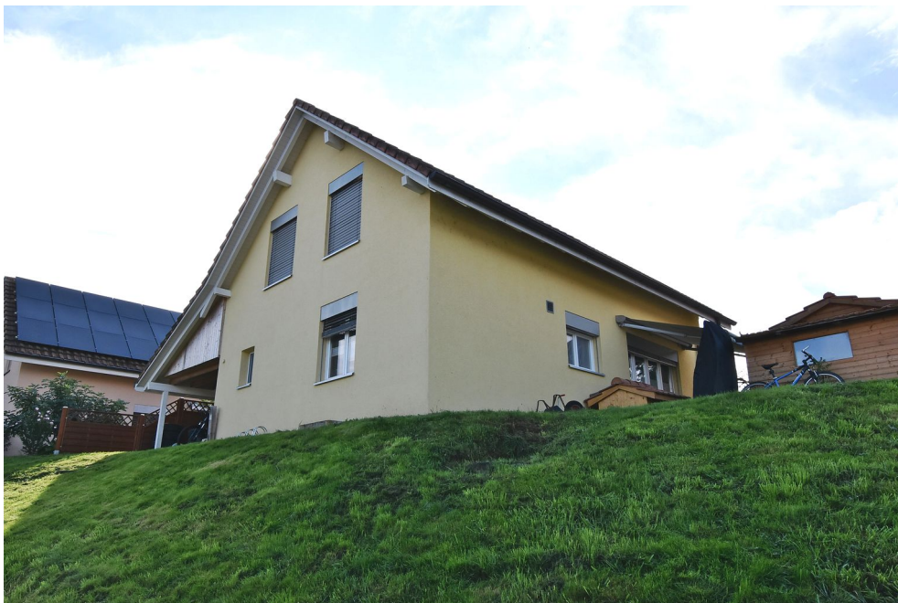
Photo N°4 Façades Ouest et Nord (talus)
