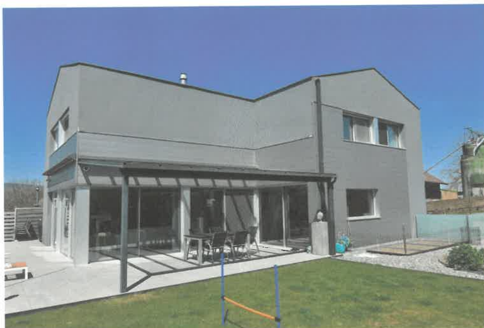
Photo N°2 Façade Sud-Est (terrasse, pergola et jardin)
