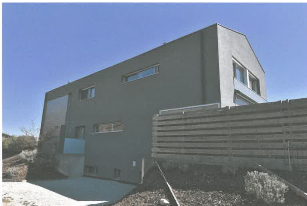
Photo N°4 Façade Nord-Ouest (entrée et fenêtres pièces de loisir du sous-sol)
