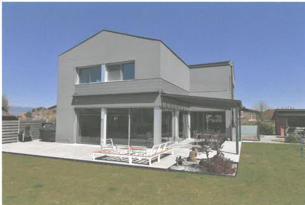
Photo N°3 Façade Sud-Ouest (terrasse et jardin)
