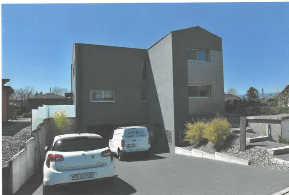
Photo N°1 Façade Nord-Est (garage)
