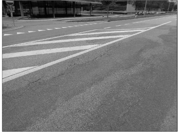
Photo 2 – RC 11 vue direction Crassier, section à trois voies devant la sortie véhicules du site de Terrebonne
