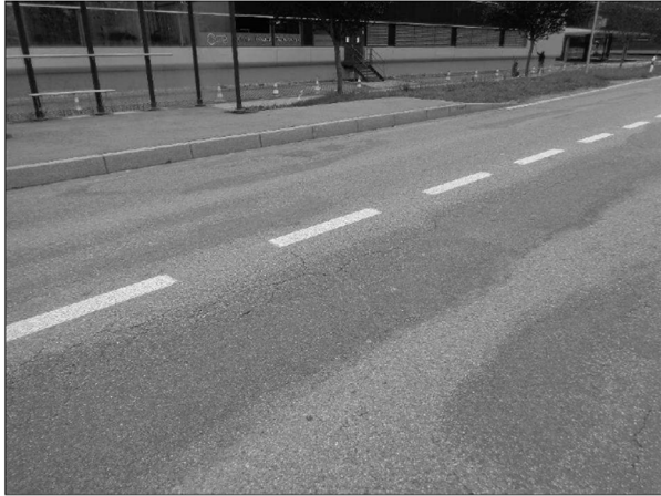
Photo 1 – RC 11 vue direction Crassier, section à deux voies devant l'arrêt de bus « Eysins, Terre-Bonne Nord »
