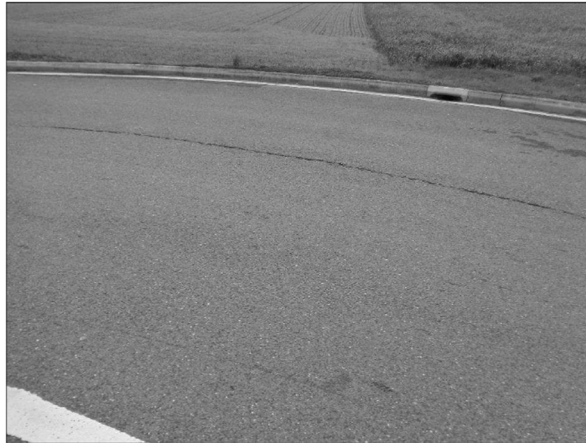
Photo 3 – carrefour giratoire de Terrebonne
