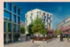
Gymnase de Crissier En location Construction en cours
