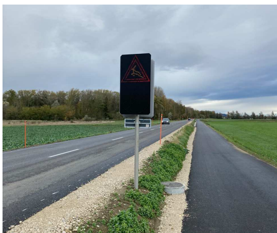
Figure 12 : Système d'avertisseur de la présence de gibier de type Calstrom
