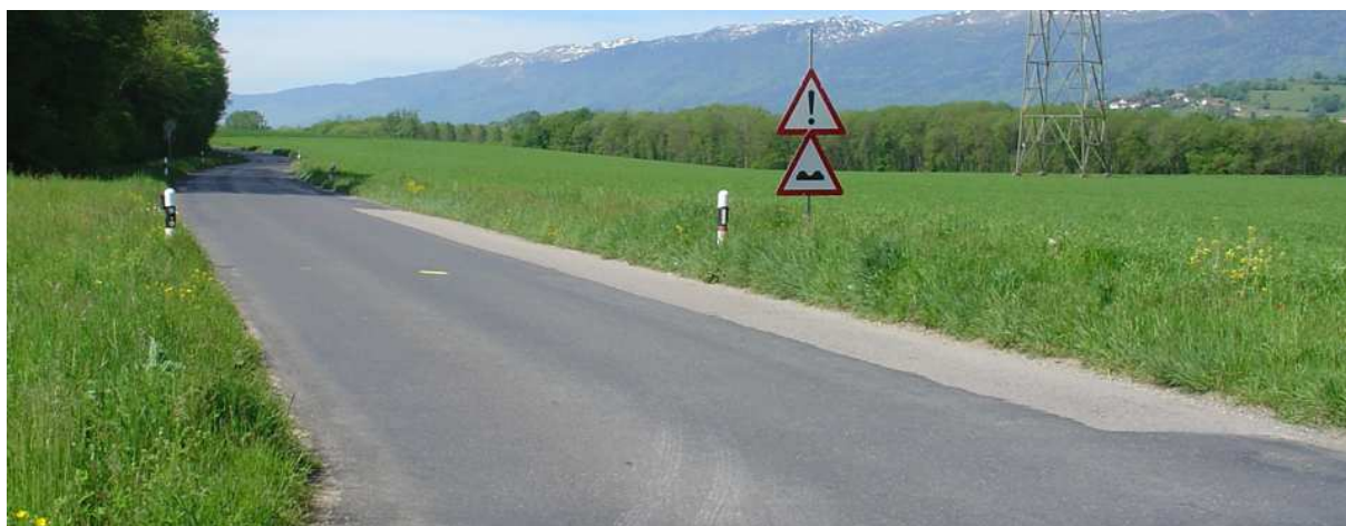
Figure 2 : Réfection provisoire d'un affaissement de bord de chaussée
