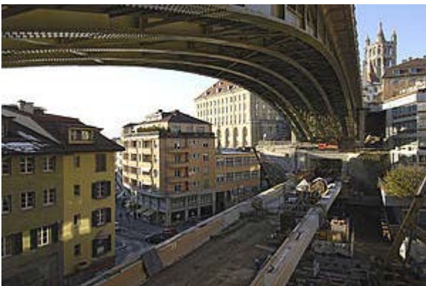
Rame de métro m2 en construction (c) t-I/J. - B. Sieber
