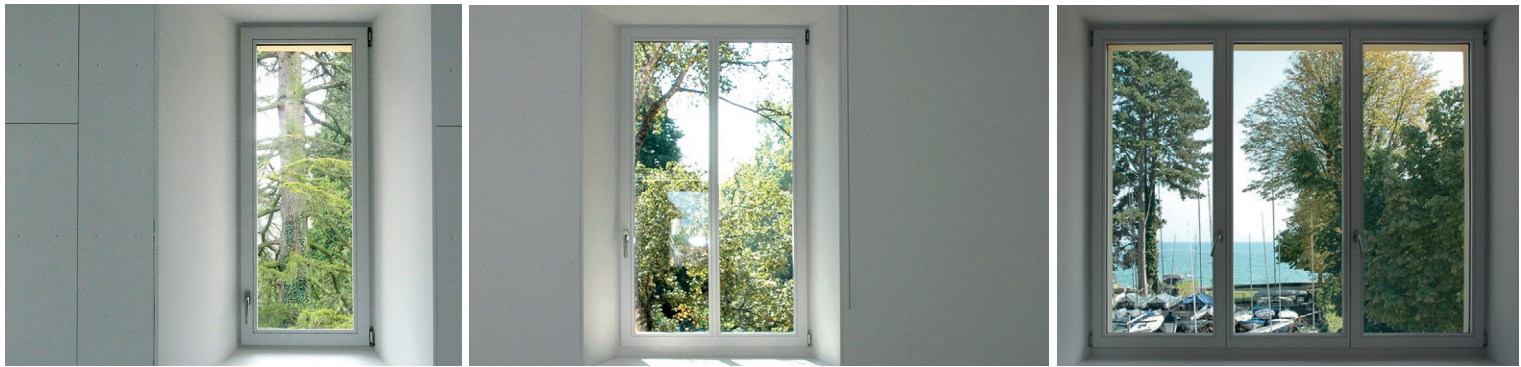
Doublage façade parc
