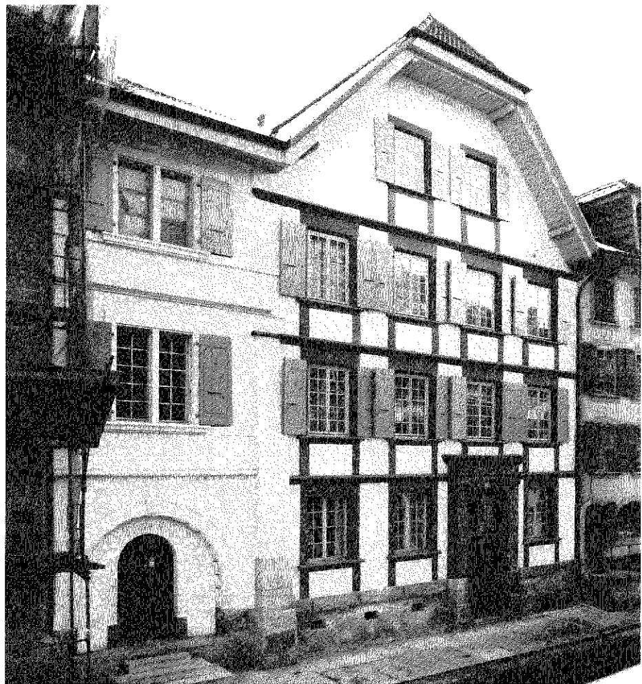
Etat après travaux
