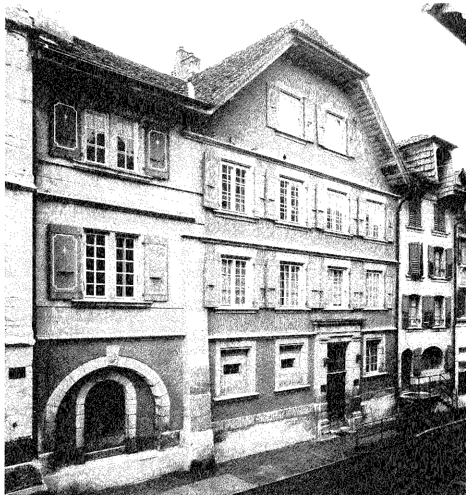
Façade côté rue de Grenade
