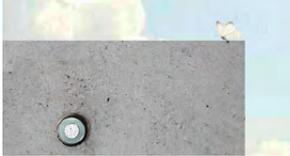
Douze capteurs sont situés sur le haut de la tour sur trois murs orientés vers le soleil. Leur intégration sur la façade est discrète et peu visible depuis le bas. Un verre assure l'étanchéité et la pérennité de l'installation.
