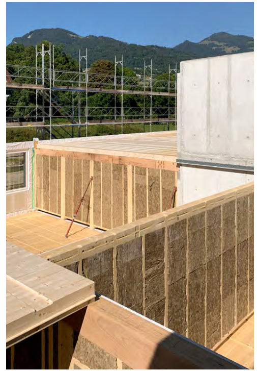
montage parois en ossature bois sur chantier
