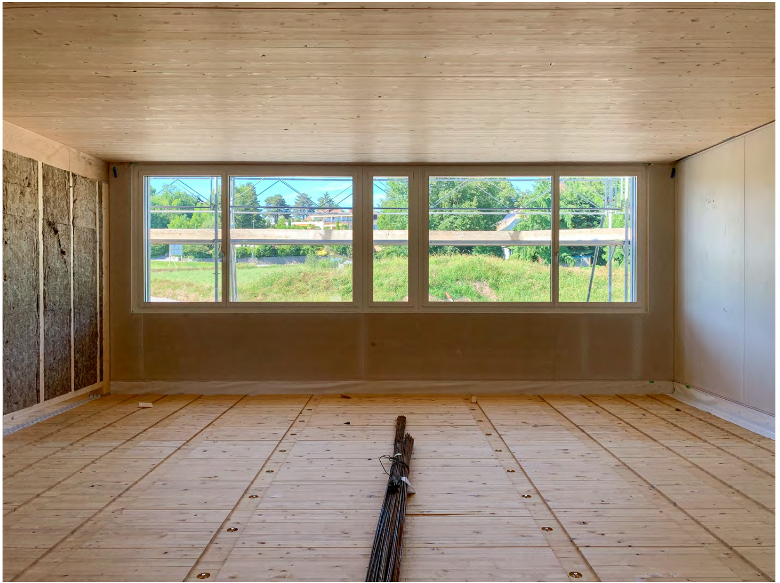
vue d'une salle de classe après montage
