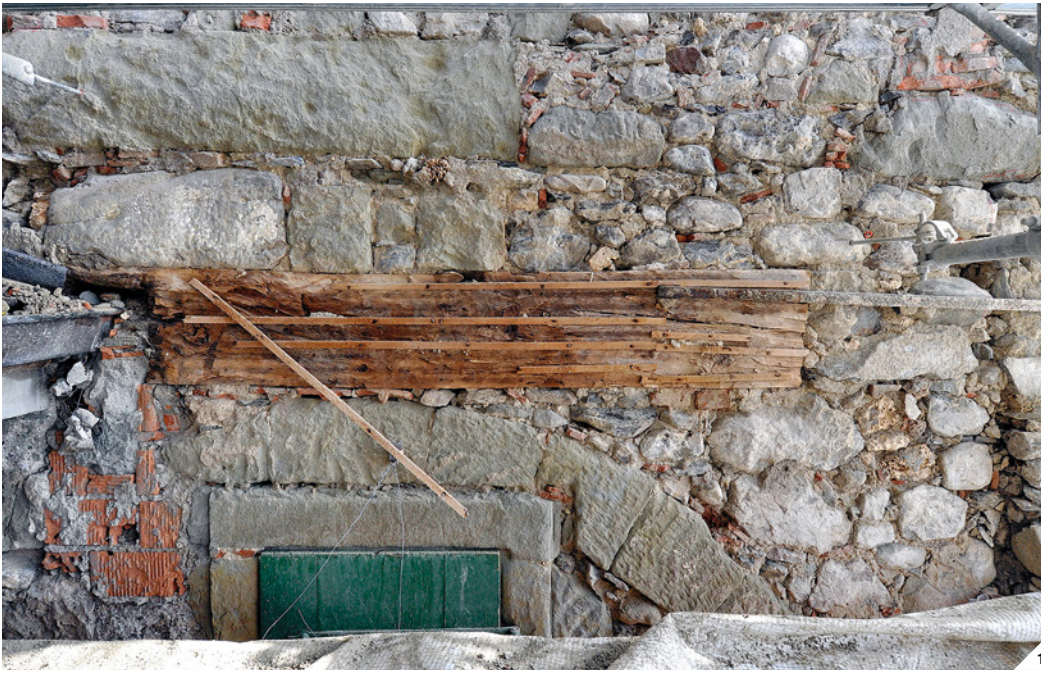
1/ Façade nord-ouest: poutre de chêne de 1585 située au-dessus de l'arc en molasse du passage dans la maçonnerie de la phase 2. Les blocs en molasse visibles au-dessus de la poutre font partie de la tablette de la fenêtre de l'étage (voir fig.5) (RÉF. ARCHÉOTECH: AJM_DSC4367.JPG).
