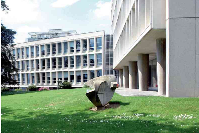
Siège de la Vaudoise Assurances, 1954, Jean Tschumi, Lausanne
