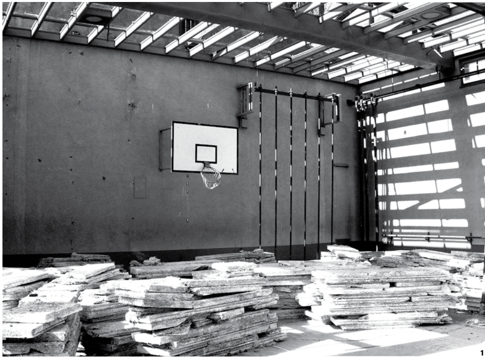
1/ déconstruction de la salle de sport de 1952 2/ nouvelle salle de sport
