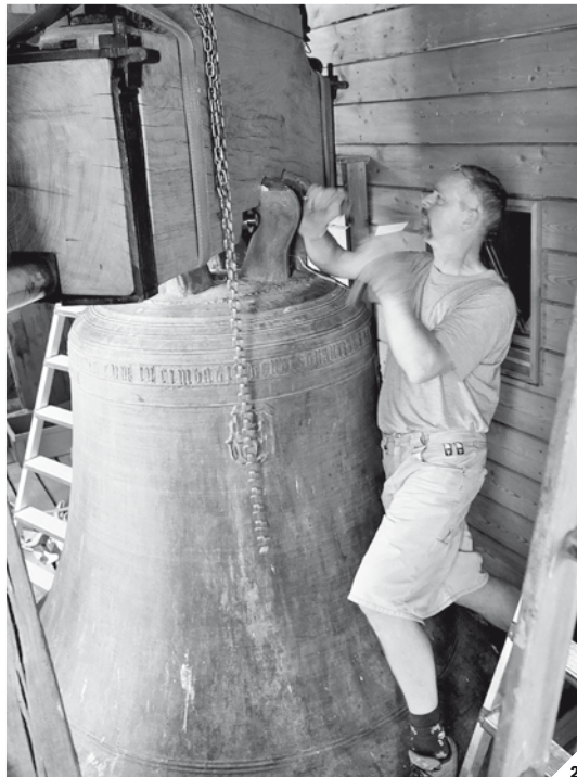
1/ Cloche n°1 Dépose de la cloche
