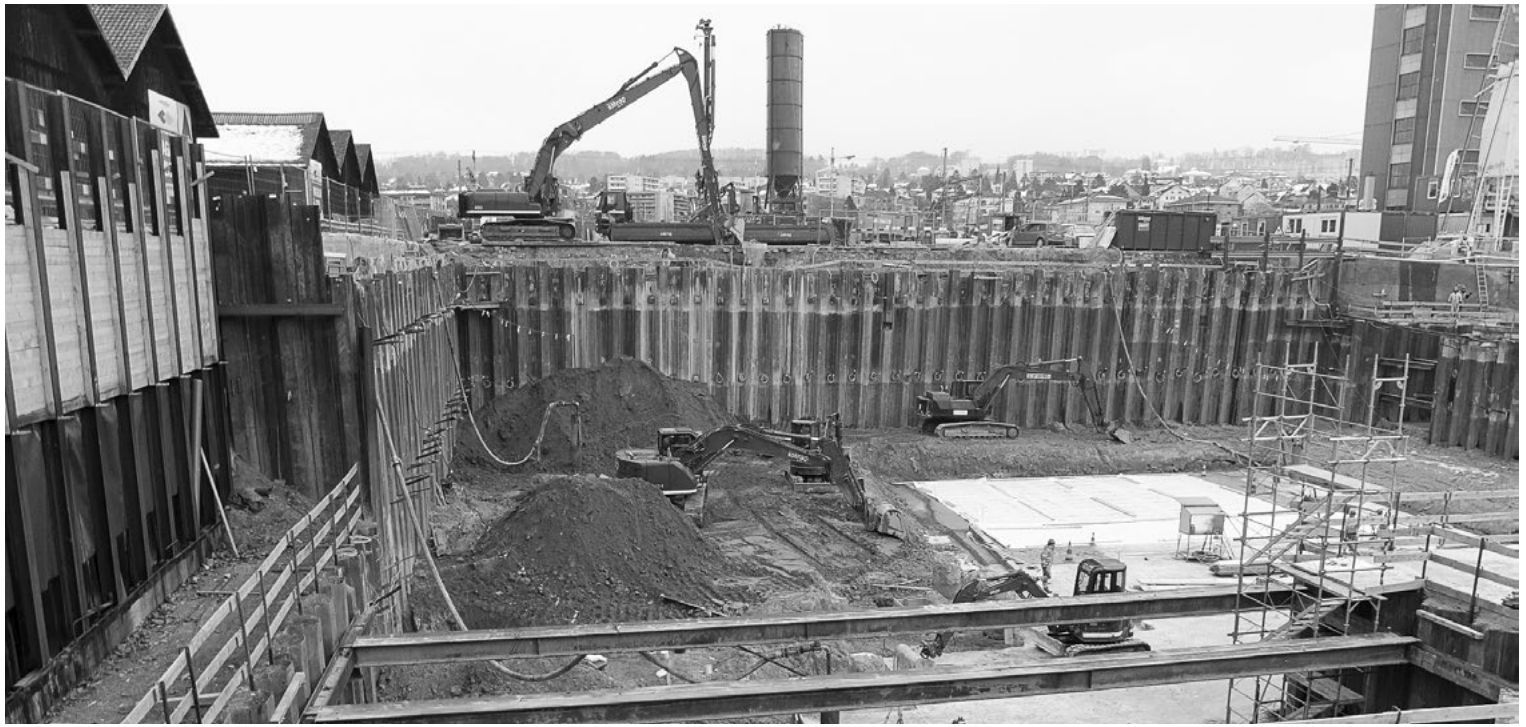
enceinte de fouille, février 2015 © DETTLING ET PÉLÉRAUX ARCHITECTES
