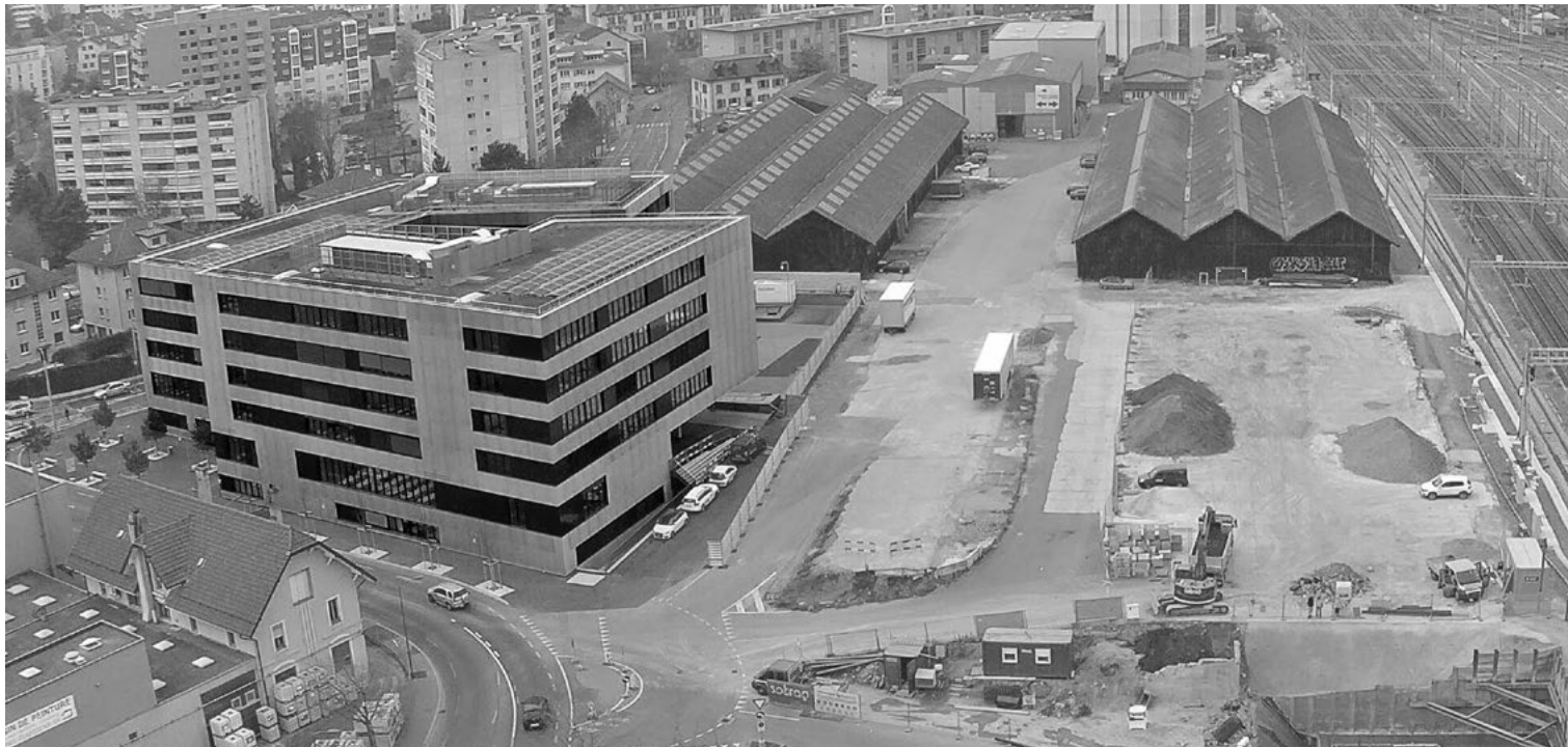
quartier des Entrepôts – Renens, décembre 2016 © SIPAL
