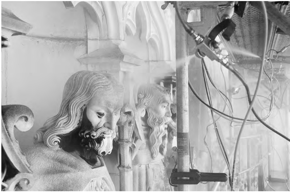
1. Suppression des croûtes noires en cours : fines gouttelettes d'eau projetées par atomisation, visage de saint Jean-Baptiste, partie haute.
