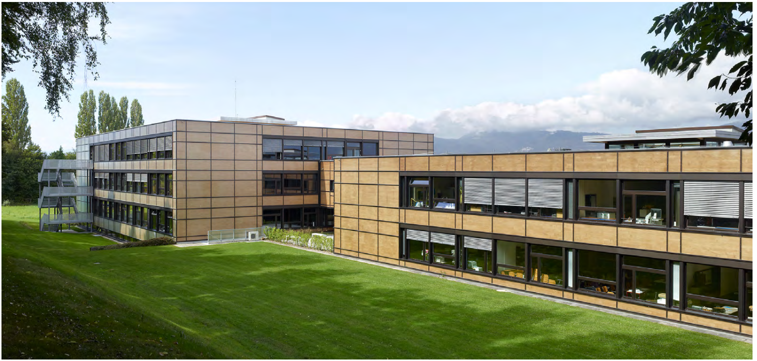
façade Sud-Est, bâtiments A et B
