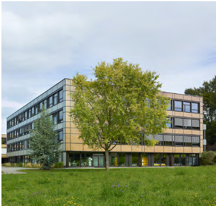
état après intervention
