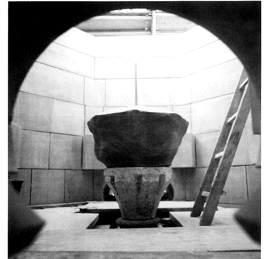
Tourelle nord Le chapiteau du « palmier » remis en place après la reconstruction des parements intérieurs. photo © C. Bornand
