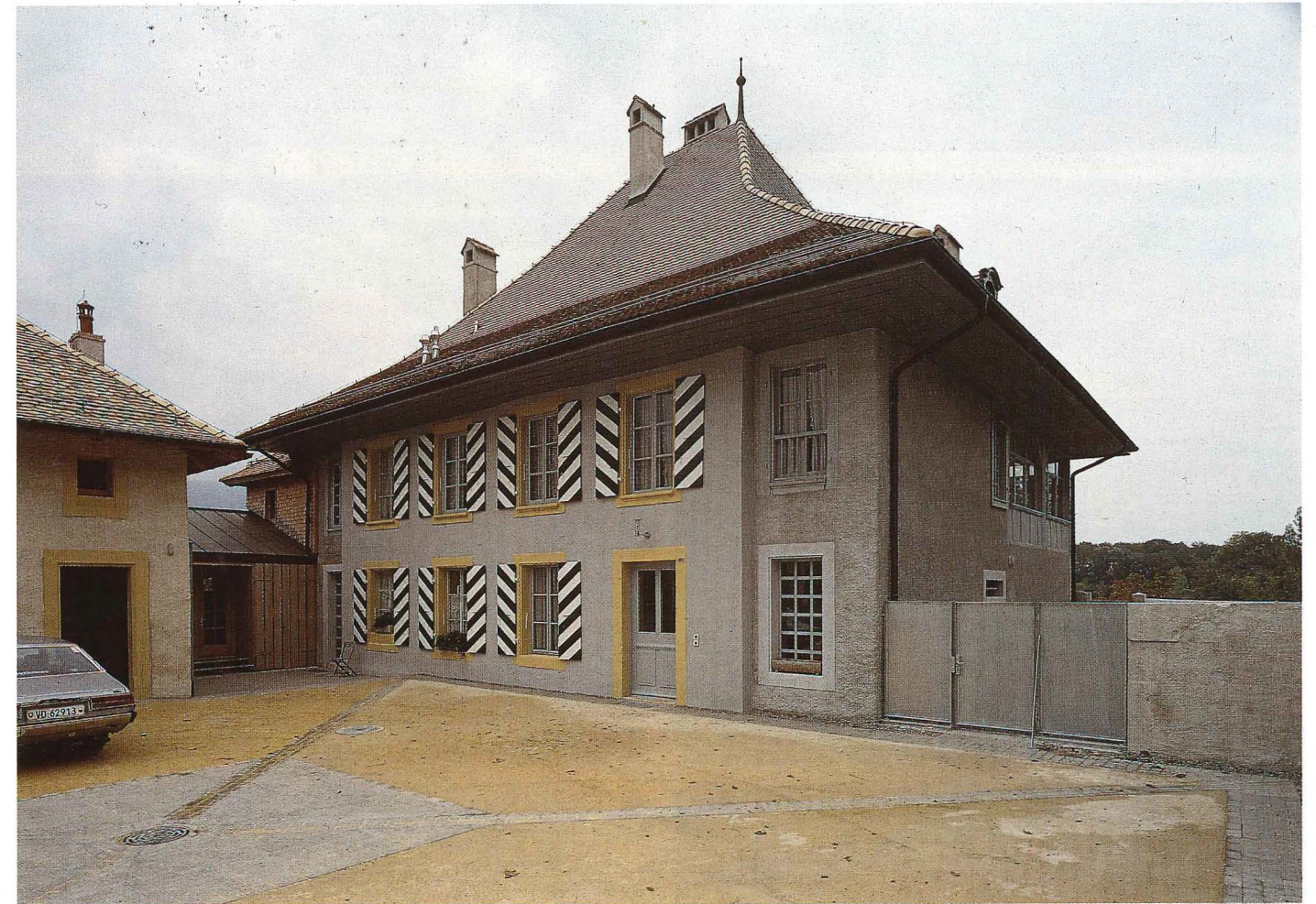
Etat actuel : nouvelle proposition acceptée par l'autorité communale (sans attestation historique propre au bâtiment).
